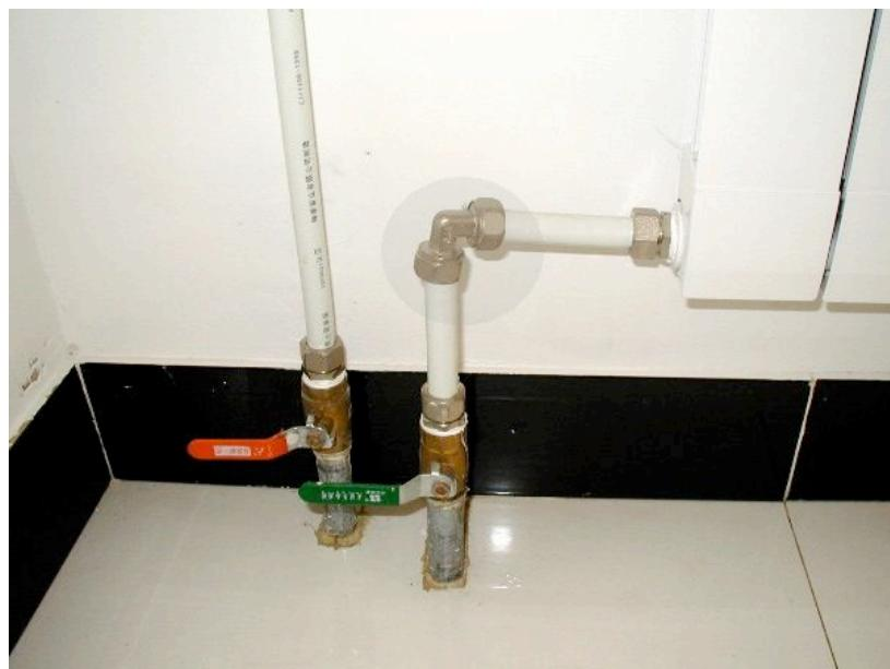
图29——我家起居室成了桑拿房和喷泉池，罪魁祸首就是管子接头太粗劣，见圆圈所示部位。
