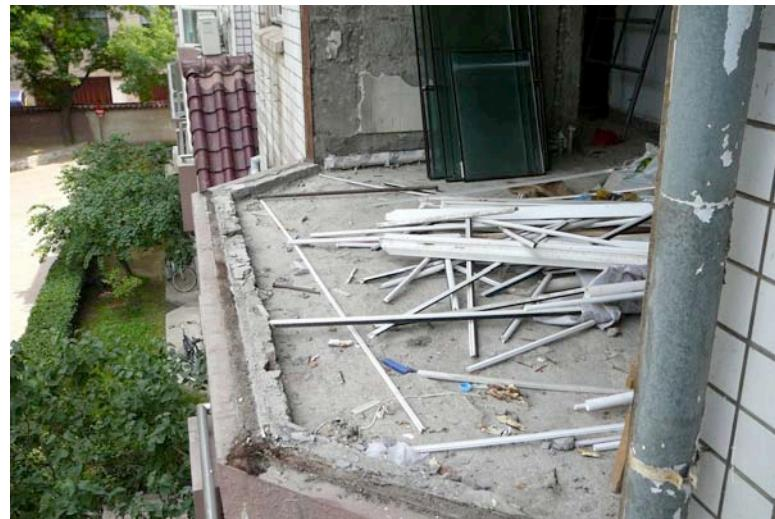
图25——原先的铝合金窗框被扔掉了。看那没了涂料的锌质雨水管。
